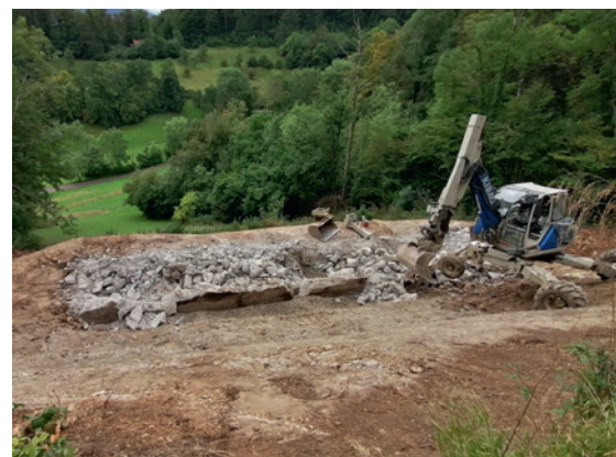
Die bestehende Betonkonstruktion wird abgebrochen, zerkleinert, abgeführt und recycelt.
